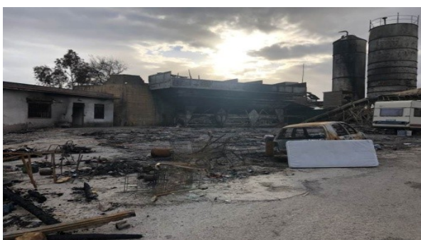
Ghetto di Campobello (TP), dopo l'incendio
